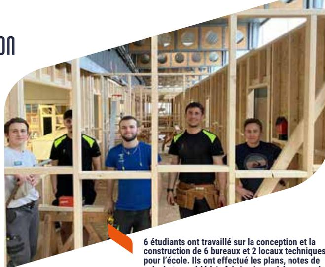
6 étudiants ont travaillé sur la conception et la construction de 6 bureaux et 2 locaux techniques pour l'école. Ils ont effectué les plans, notes de calcul et procédé à la fabrication et à la pose des murs et solivage de faux plafonds.
