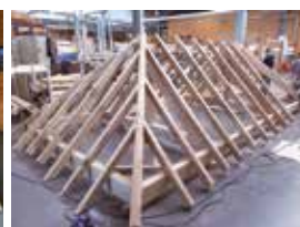
Charpente du lavoir de Bains-les-Bains
